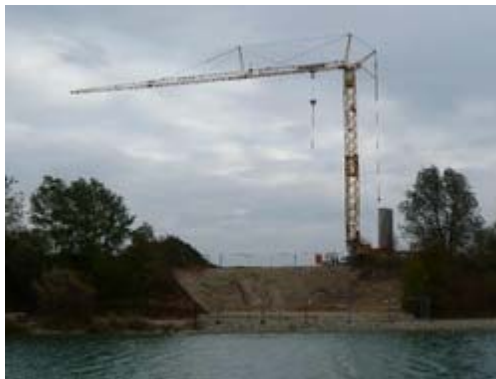
Baukran für Baustelle
