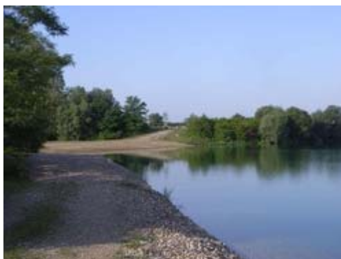
Baustellenkante zum See
