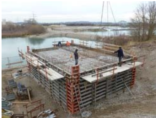
Deckenarbeiten Untergeschoss
