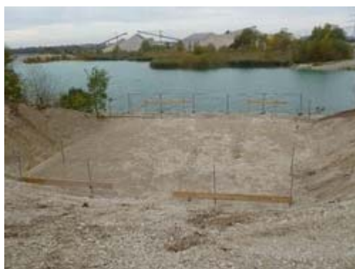
Baugrube mit Schnurgerüst
