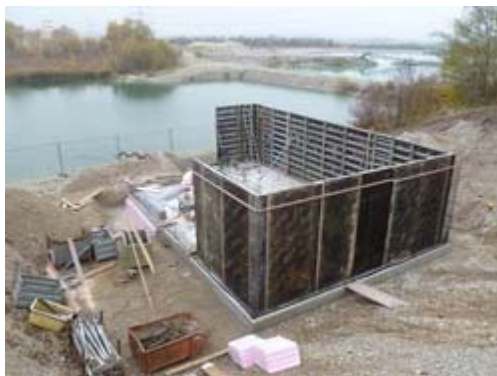
Schalungsarbeiten Untergeschoss
