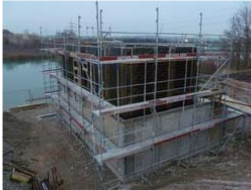
Schalungsarbeiten Zwischengeschoss
