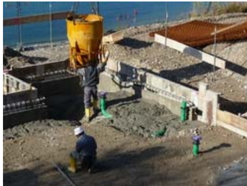
Betonierarbeiten Unterboden
