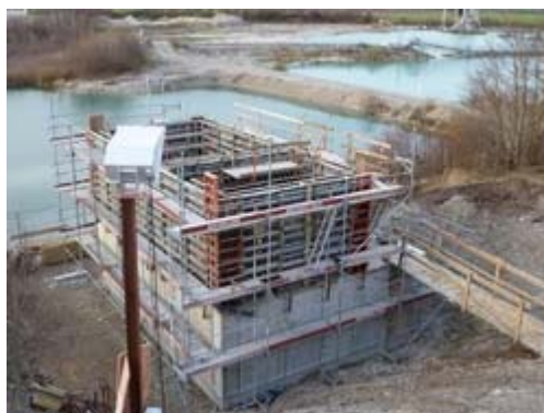
Zwischenwand im Zwischengeschoss
